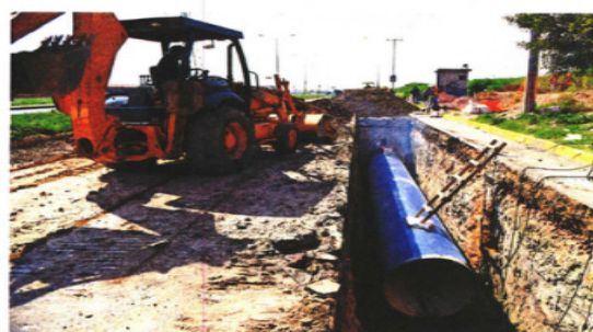
La CAEM se encargará de comprar los materiales para la nueva tubería y los municipios pondrán la mano de obra.
