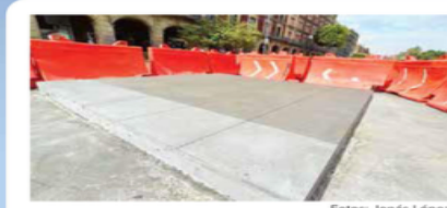
Fotos: Jonás López Se trata de un concreto de 12 centímetros de espesor, capaz de resistir el paso de tráileres y tanques.
