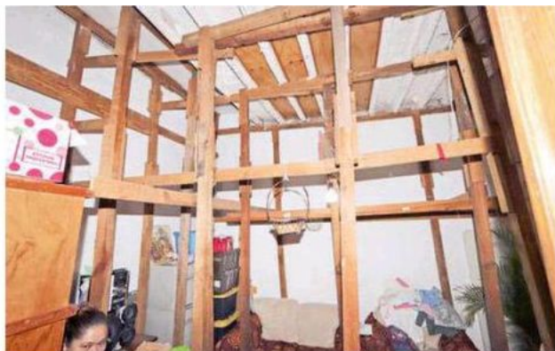
Apuntalan con polines ante los daños causados por los microsismos; los investigadores del Instituto de Ingeniería de la UNAM encontraron una grieta tectónica
