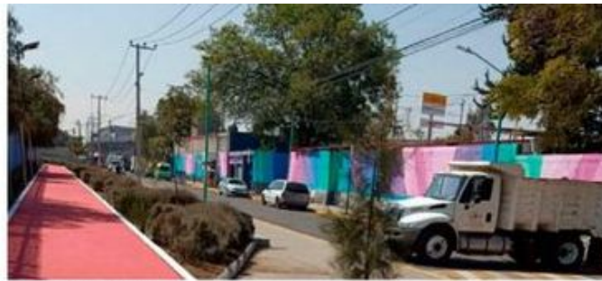
Utopía Atzintli, pintada por dentro y fuera; hasta los predios aledaños se
