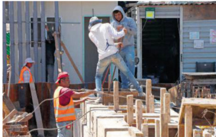
Bombeará 300 litros por segundo y beneficiará a 85 mil 500 habitantes
