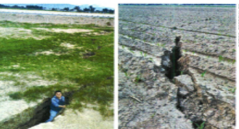
Los ejidatarios acudieron el 13 de mayo ante la Conagua para notificar de la aparición de las grietas.
