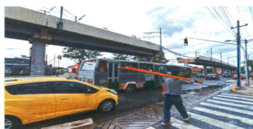
El trabajo de mantenimiento realizado por el STC en L-12 estuvo fundamentado en el manual de la empresa Systra, dijo el titular del Metro.
