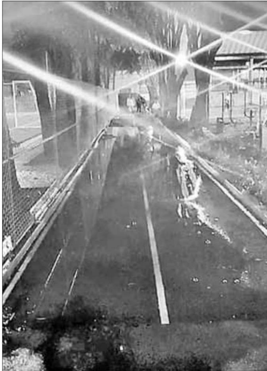
► De acuerdo con los vecinos, aunque todavía no se abre al público, la obra ya exhibe deficiencias. Foto La Jornada
