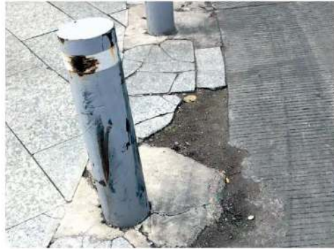
Banquetas de Mazaryk, en pésimo estado
