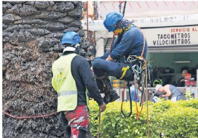
Los trabajos para cambiar palmeras iniciaron en Vértiz, en el tramo de viaducto Miguel Alemán a División del Norte, informa la Sedema.
