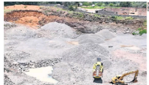
En la mina ubicada en San Felipe del Progreso explotaban materiales de construcción como grava y arena.
