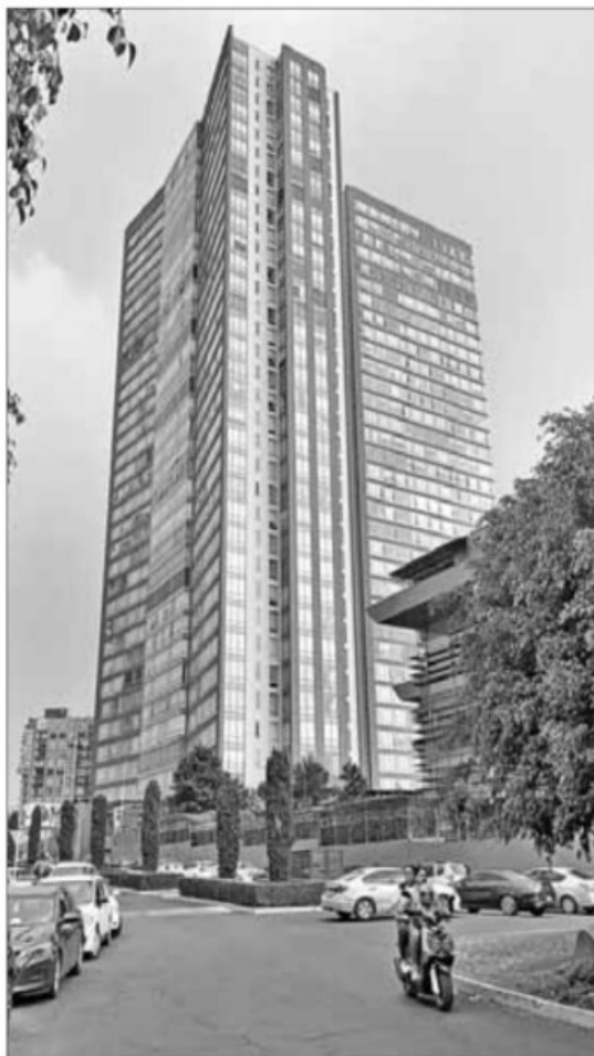
▲ La construcción de la segunda torre del complejo High Park Sur (derecha) concluyó recientemente y 50 departamentos ya están habitados, afirmó el abogado Rodrigo Muñoz. Foto José Antonio López
