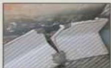
**02** Se registran fracturas en las trabes con desprendimiento de material de los refuerzos.
