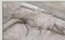
**05** La distancia entre el acero de refuerzo y la superficie superior de la losa no refleja las dimensiones requeridas de recubrimiento.
