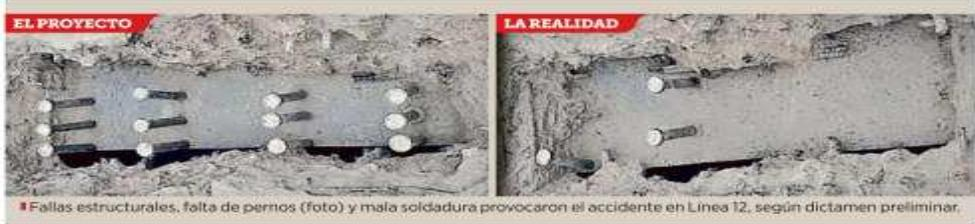
Fallas estructurales, falta de pernos (foto) y mala soldadura provocaron el accidente en Línea 12, según dictamen preliminar.
