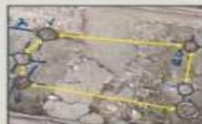
**04** Cantidad de pernos menor a la requerida, distancia de separación no uniforme y la falta de eliminación de la cerámica de protección, que incumple con los planos de la obra.
