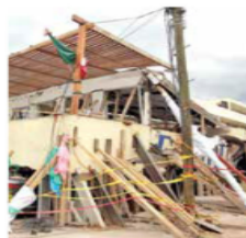
Aspectos del Rébsamen tras el colapso del 19-S.
