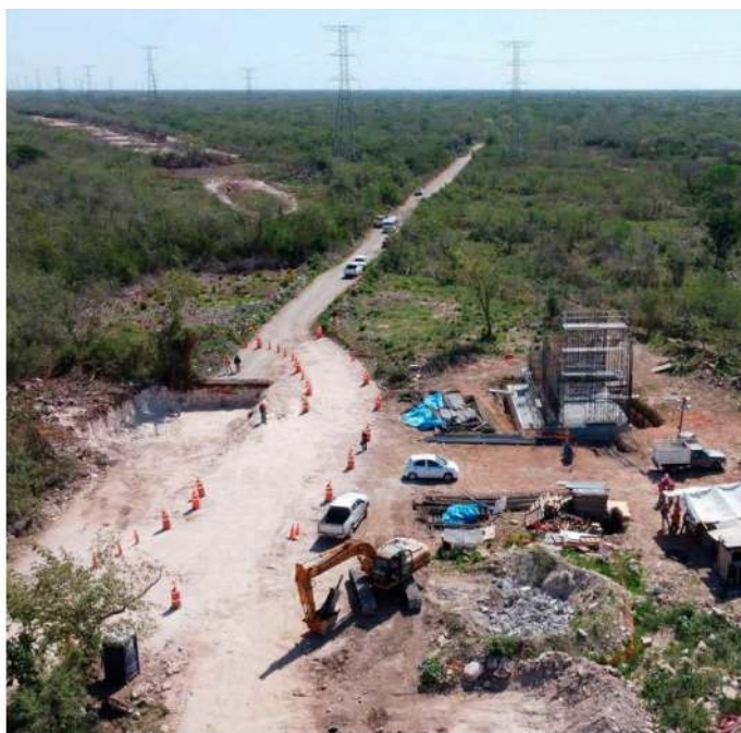
Trabajos en tramo 5 del Tren Maya se dan sin autorización ambiental.
