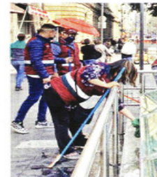
A la fecha, se contabilizan alrededor de mil 850 puntas de varillas retiradas.
