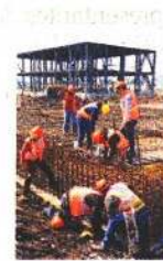
Obras del Trolebús
