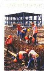
Obras del Trolebús
