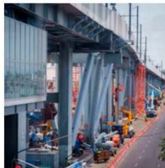
Tras los señalamientos, el Metro reafirmó que los postes no tienen ninguna función de carga en la estructura del viaducto.
