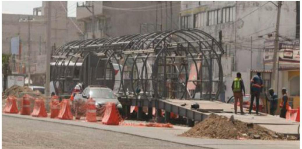
Instalación de una de las estaciones del Mexibús mediante sistema prefabricado de acero.
