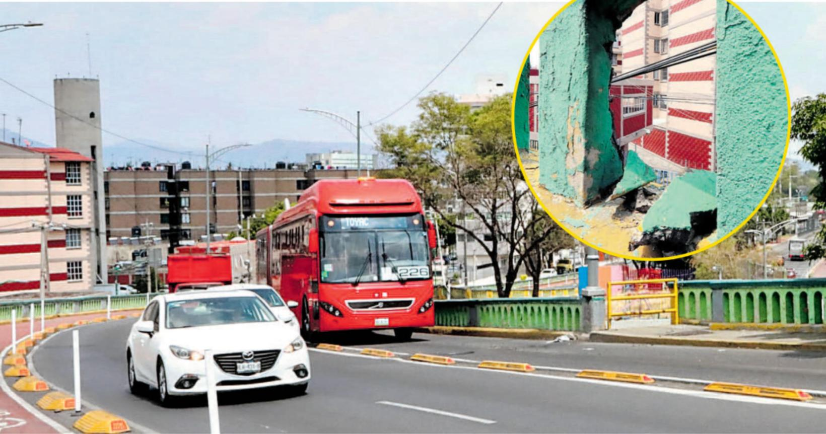
En esta zona las unidades avanzan a 10 kilómetros por hora. La barra de contención tiene desprendimientos de concreto
