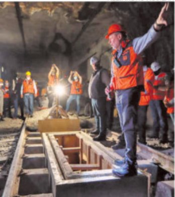
El Metro remodelará su drenaje
