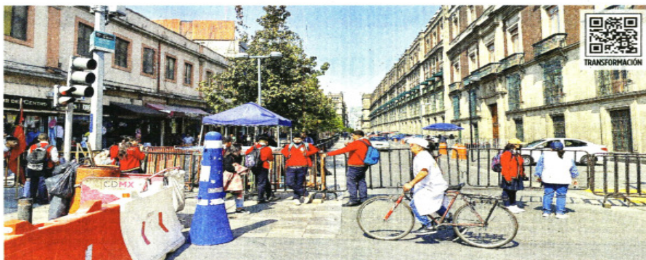
AHORA. El área se enrejó y cuenta con vigilancia permanente para que sólo ingresen los vehículos autorizados.
