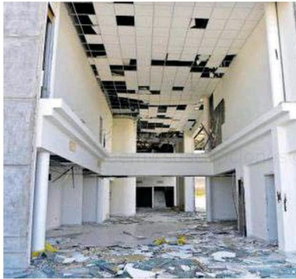
Predio que será la nueva estación migratoria
