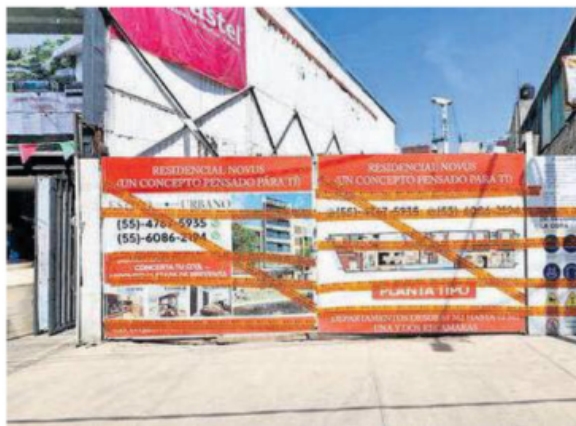
En este predio se construían departamentos de hasta 72 m2
