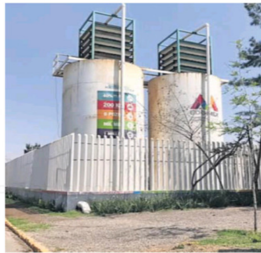
El proyecto contemplaba la construcción de plantas potabilizadoras, plantas de rebombeo y perforación de nuevos pozos.
