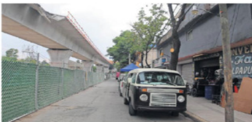
La zona donde hace un mes se cayó una dovela está cercada por una reja; la Secretaría de Obras afirmó que está por llegar maquinaria.
