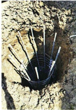
En la obra se llevaban a cabo tareas de perforación.
