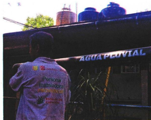
Un grupo de técnicos trabaja en la instalación de tuberías para cosechar lluvia, constató EL UNIVERSAL.
