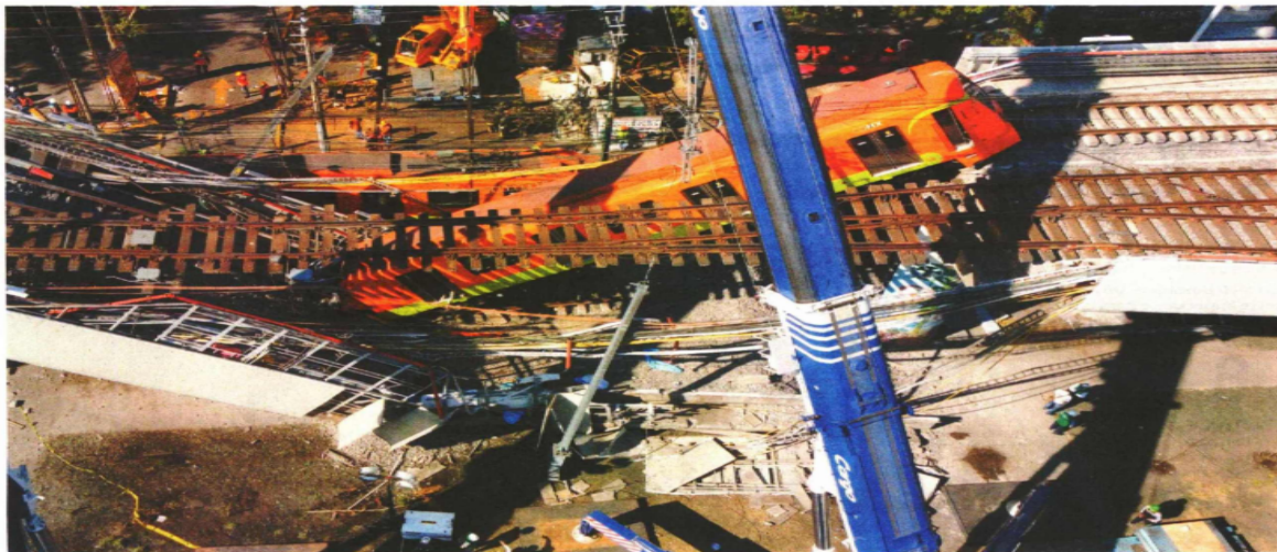
La mañana del martes fueron retirados los trenes colapsados con la ayuda de dos grúas. Autoridades cercaron el perímetro para evitar más accidentes.
