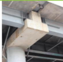
La principal falla se dio en la columna 69, del tramo Nopalera-Olivos, registró agrietamiento de concreto en la zona de máximo esfuerzo
