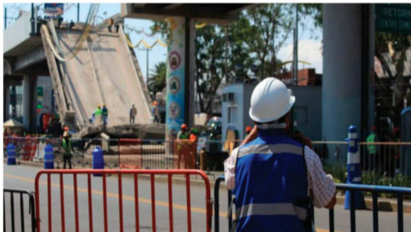
El dato: murieron 26 personas por el colapso en la Línea 12 del Metro de la CDMX.
