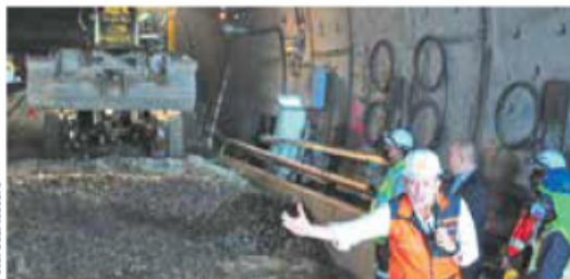
Serán rehabilitados 4.5 kilómetros de los 11.9 del túnel
