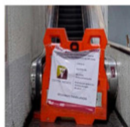
Escaleras eléctricas, sin funcionar.
