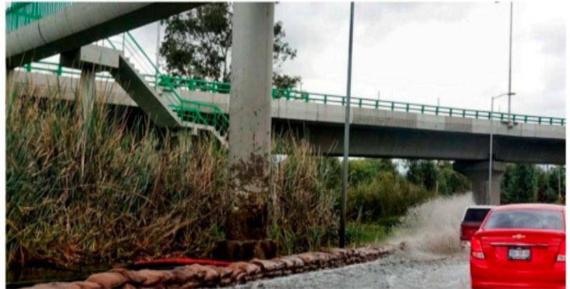
El puente vehicular "Cielito Lindo" sufre de encharcamientos ya que fue construido bajo un humedal.
