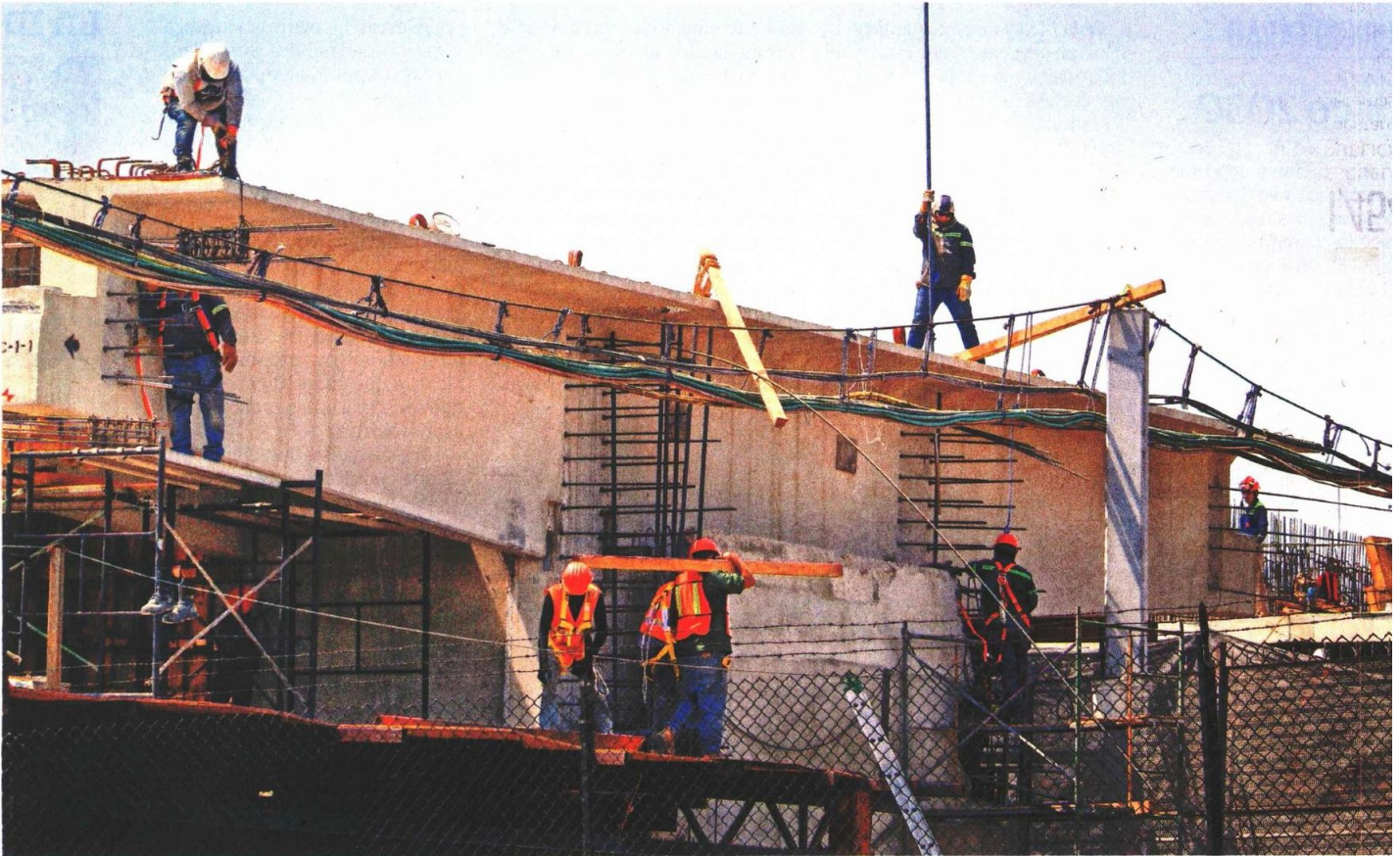
Trabajadores de la Secretaría de Obras reconstruyen el tramo elevado hacia Pantitlán, para evitar el desnivel registrado en esta parte.
