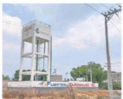
Fuerza Xiutequitl apoyó a habitantes en la operación del pozo.
