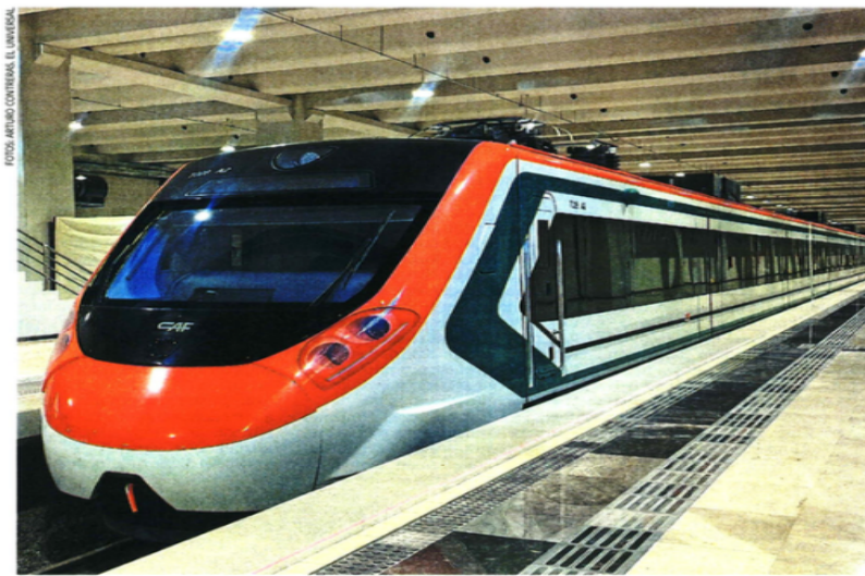
De los 46 kilómetros, 32 ya fueron terminados, en proceso se encuentran 13 kilómetros y uno más está por iniciar; ya se hicieron pruebas con uno de los trenes.
