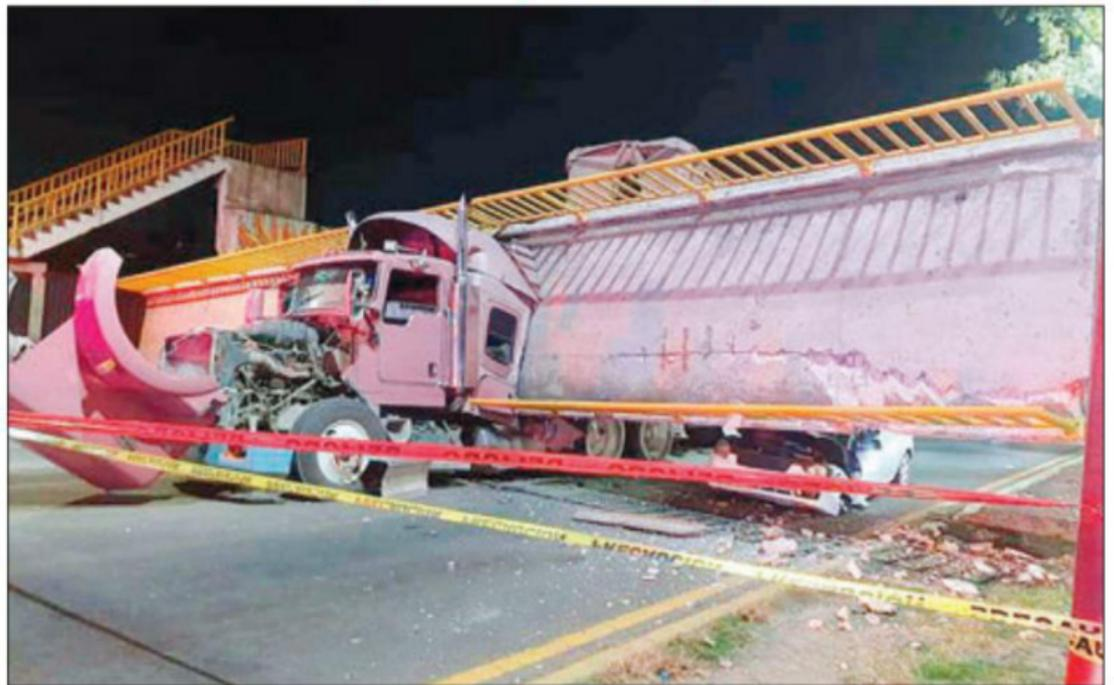
▲ El percance ocurrió en la carretera federal Los Reyes-Texcoco, a la altura del poblado Cuautlalpan, estado de México. Todo indica que el vehículo, un Kenworth placas 29AF6W, excedió las dimensiones reglamentarias, colisionó con la estructura superior, la cual colapsó
