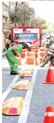
Los trabajos, que incluyen confinamiento, balizamiento y señalización, lucen con un avance importante.
