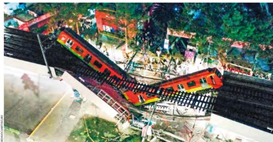
**PERITAJE.** Se determinó que la falla se originó en la viga izquierda, debajo de la vía con dirección hacia Tláhuac, arrastrando posteriormente la derecha, ocasionando el colapso total en 1.9 segundos.
