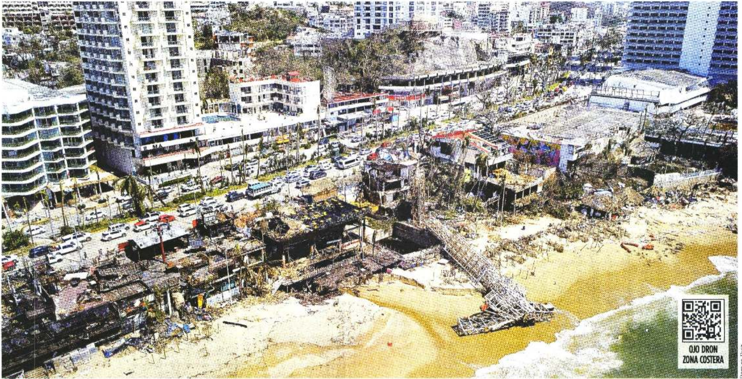
ESCOMBROS. La tradicional zona de bares y restaurantes en la Costera del puerto de Acapulco, por completo devastada por los efectos del huracán.
