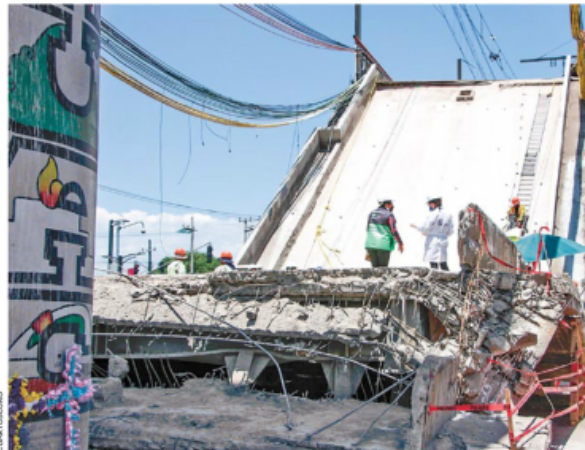
SOLDADURA DEFICIENTE. El 3 de mayo pasado un tramo elevado se desplomó justo cuando pasaba un tren.
