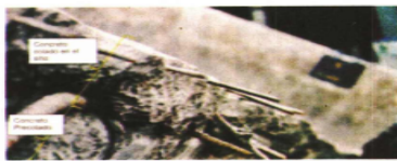
Fotografía que muestra las varillas de acero de refuerzo con evidencia de sobrecarga dúctil.
