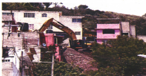
Retruxoexcavadoras tiran lo que queda de las viviendas más afectadas por el deslave de rocas del cerro, ocurrido hace 17 días.
