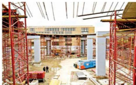
El retorno, en donde los trolebuses completarán el circuito, está en fraguado y el concreto se sostiene con andamios.
