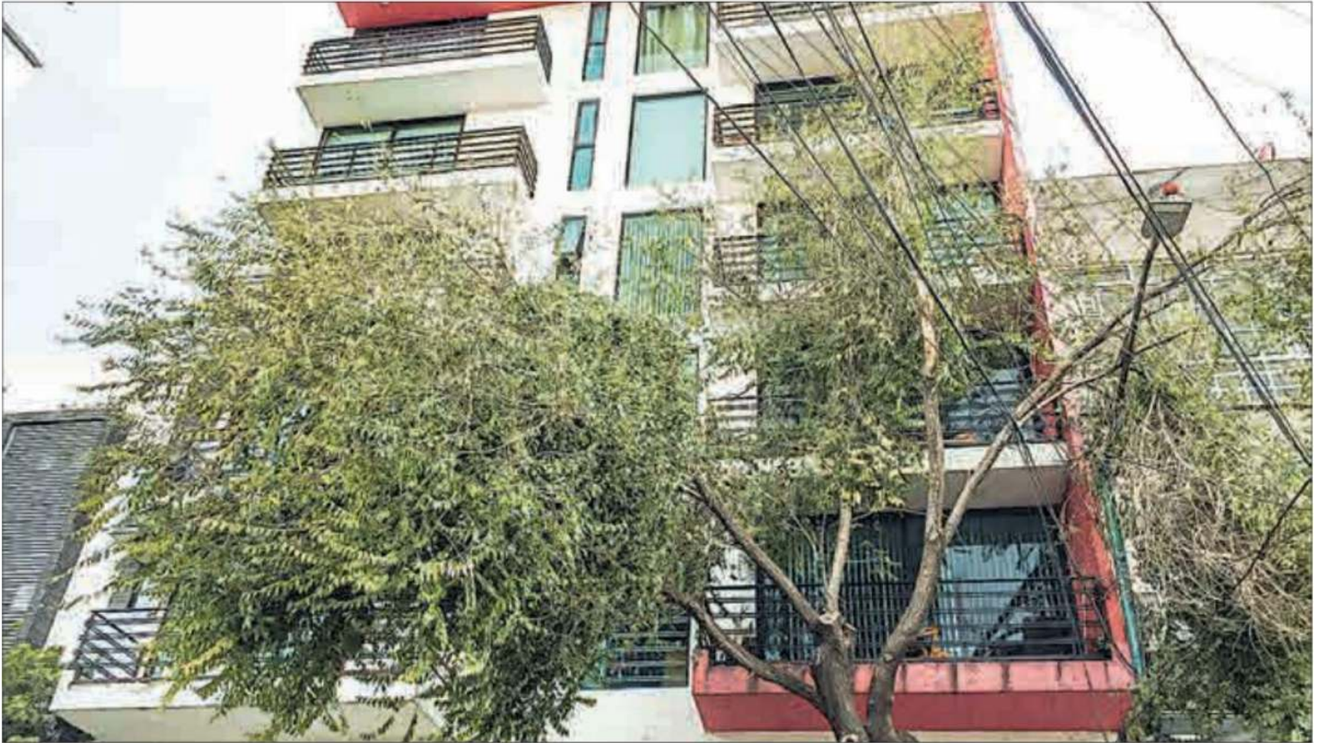
◀ Vista frontal del edificio ubicado en la calle Bengala 7, colonia Zacahuitzco, alcaldía Benito Juárez, donde hace siete años se construyeron pisos adicionales de manera ilegal. Foto Cristina Rodríguez
