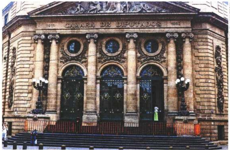
Previo al inicio de sesiones, concluyeron los trabajos de limpieza en la fachada del Congreso local, luego de que fue vandalizada por colectivos.
