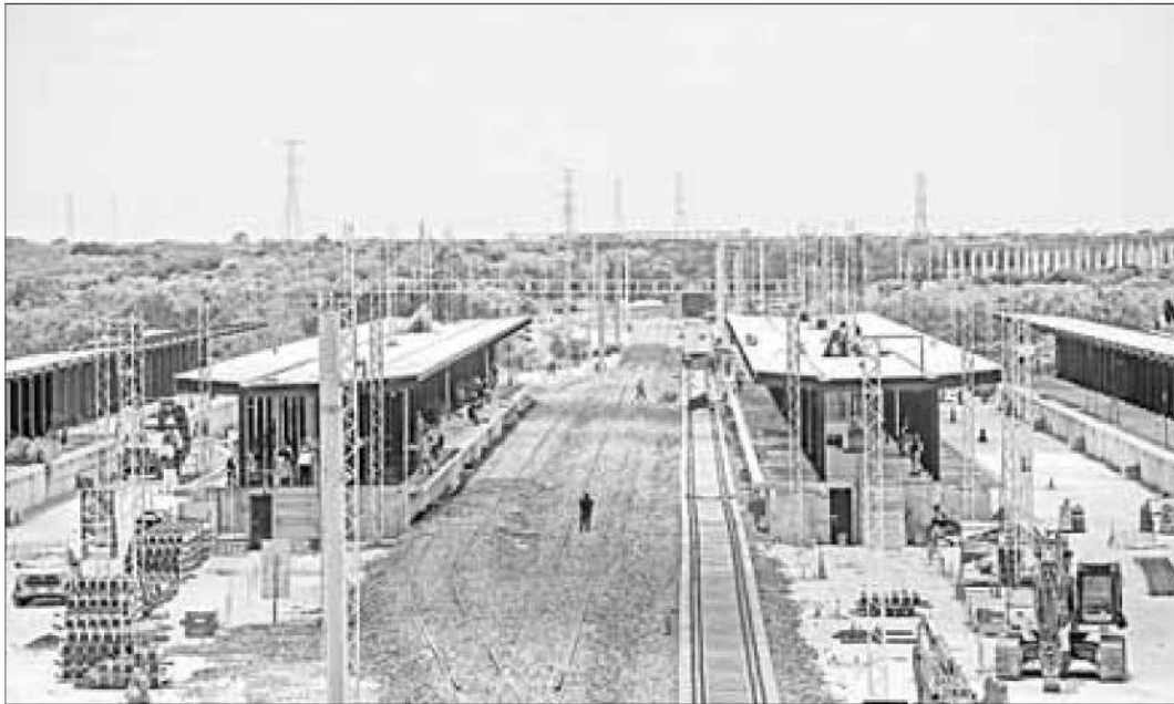
▲ Construcción de la estación Teya del Tren Maya, en Yucatán. Foto Luis Castillo
