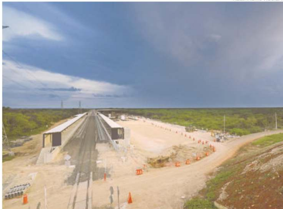
Obras del Tren Maya en el tramo que pasa por Calkiní, Campeche
