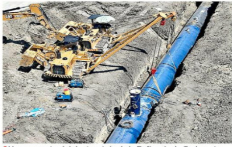
Un segmento del ducto, atrás de la Refinería de Cadereyta, es sostenido por dos grúas para apenas ser unido ayer.
